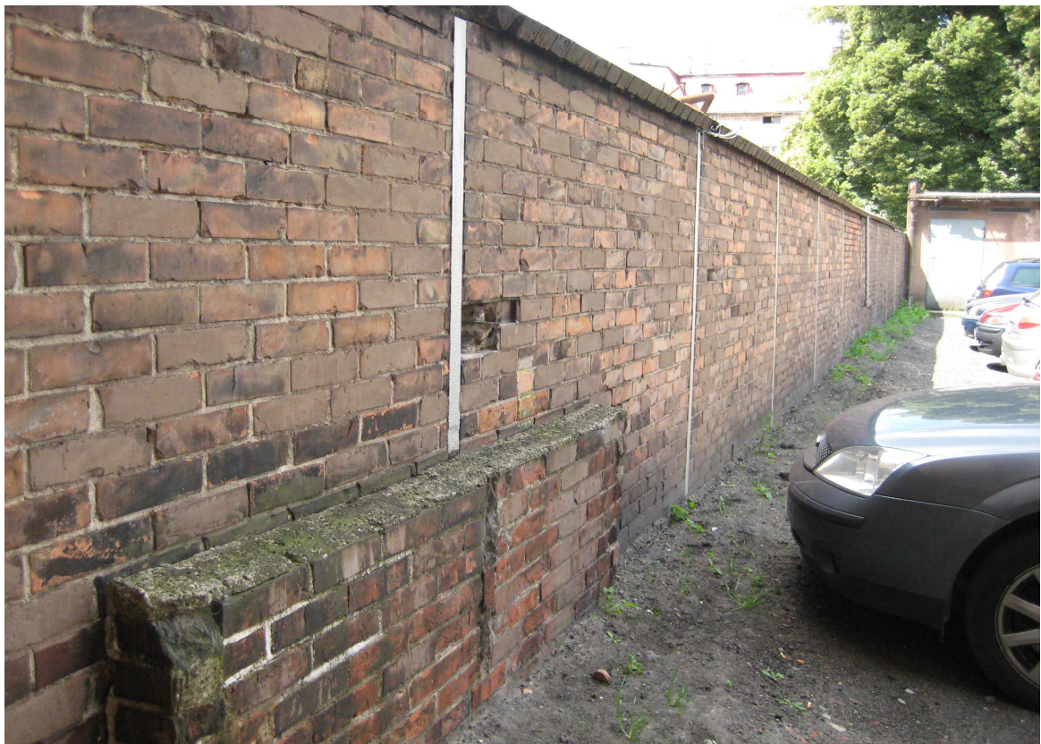
Fot. Nr 2 – Widok muru od strony działki Nr 12
