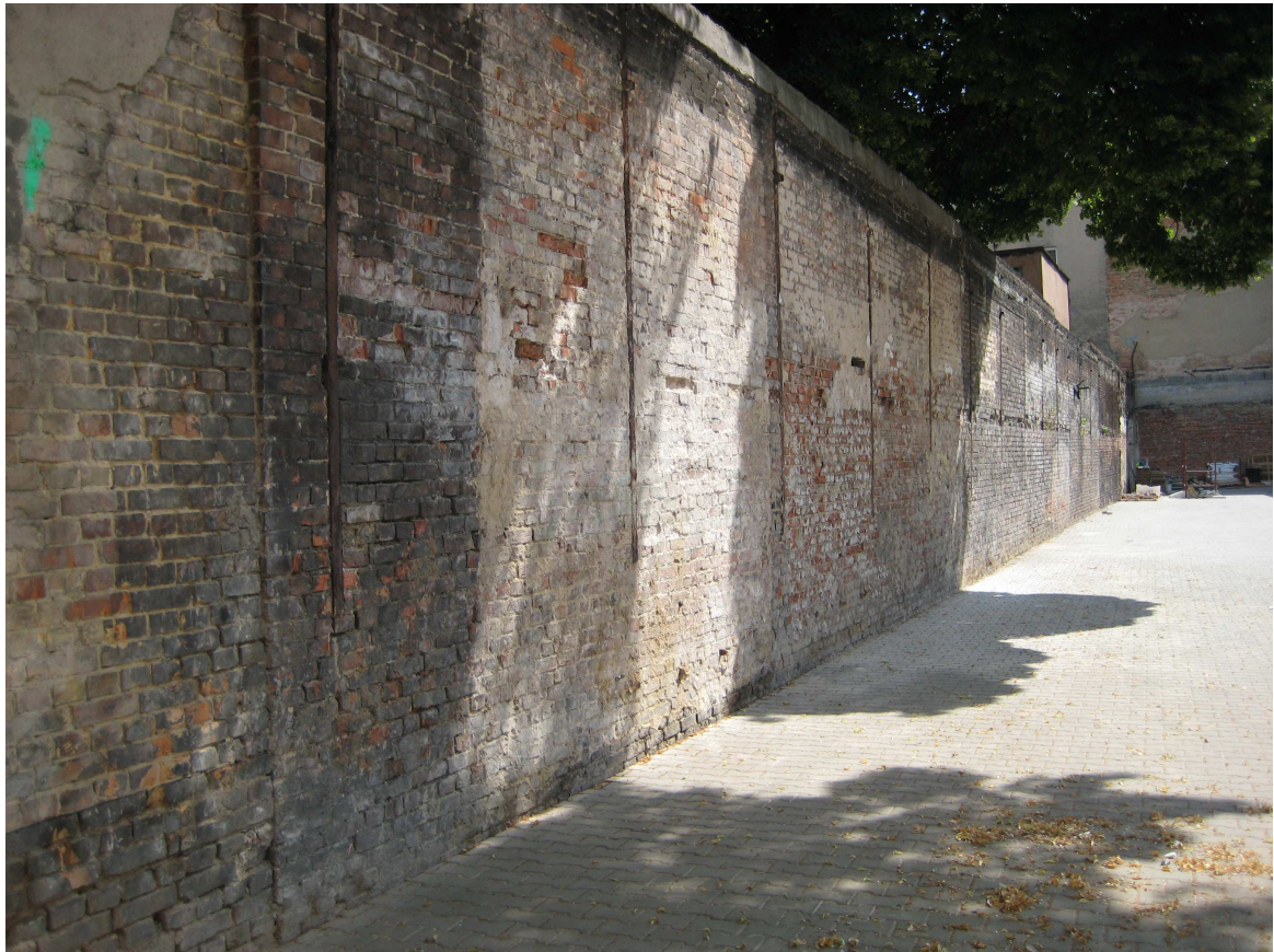
Fot. Nr 1 – widok muru od strony działki Nr 16/3
